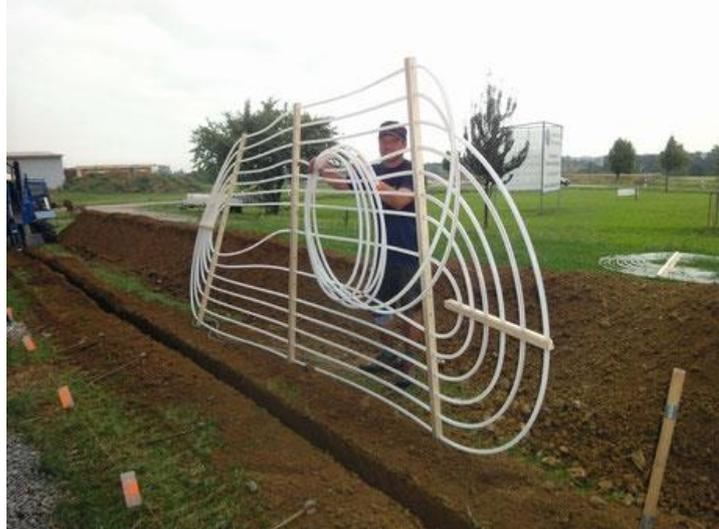
**Abbildung 0-1 Verlegung von horizontalen (links) und vertikalen (rechts) Agrokollektoren (Quelle: Steinhäuser GmbH & Co. KG)**
