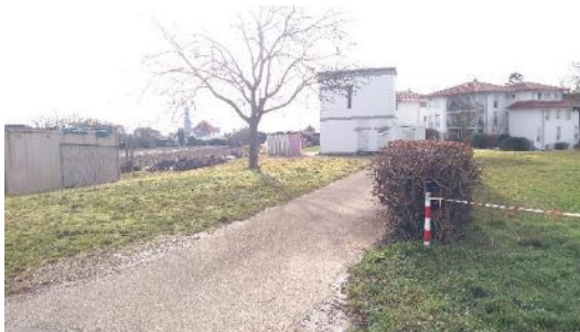
Blick auf das bereits vorhandene Versorgungshaus (02/2021)
