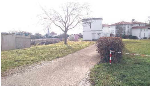
Blick auf das bereits vorhandene Versorgungshaus (02/2021)
